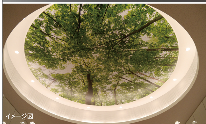
ウェット工法にて 400R 以上の曲面加工が可能
